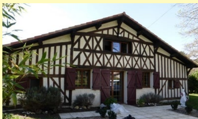
Parentis-en-Born. Quartier d'Eseleys. Maison dite du préfet, datant de 1770. L'auvent originel a été maçonné. Pans de bois et vraisemblablement torchis à l'origine.
