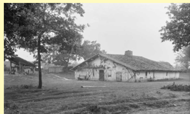
Pontenx, quartier de Bouricos. Maison sans auvent, pans de bois et torchis. Photographie Félix Arnaudin, fin XIXème siècle.
