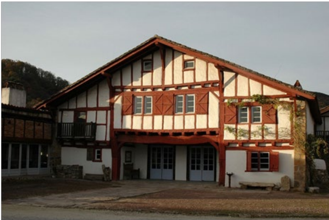
Labourd, Saint-Pée-sur-Nivelle. Maison Inharria.
