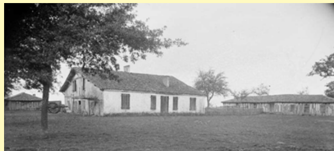
Parentis-en-Born, quartier du Bô. Ancienne maison Larreillet. Pans de bois, torchis et partie maçonnée vraisemblablement en garluche. Photographie Félix Arnaudin, 26 octobre 1901.
