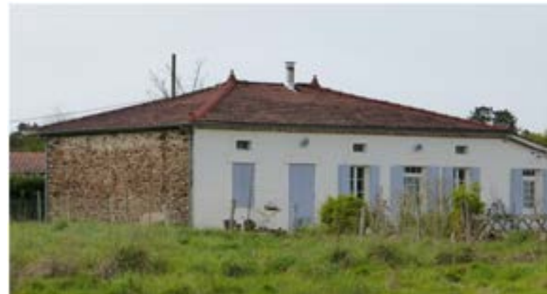
Biscarrosse, Millas. Maison en garluche et crépis blanchi. 1910. Etat actuel. Tuiles mécaniques plates.
