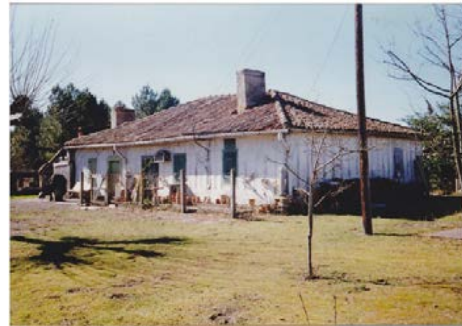
Biscarrosse, Pierricq. Maison à pans de bois et torchis. Première moitié du XIX ème siècle. Tuiles romanes canal. Etat ancien.
