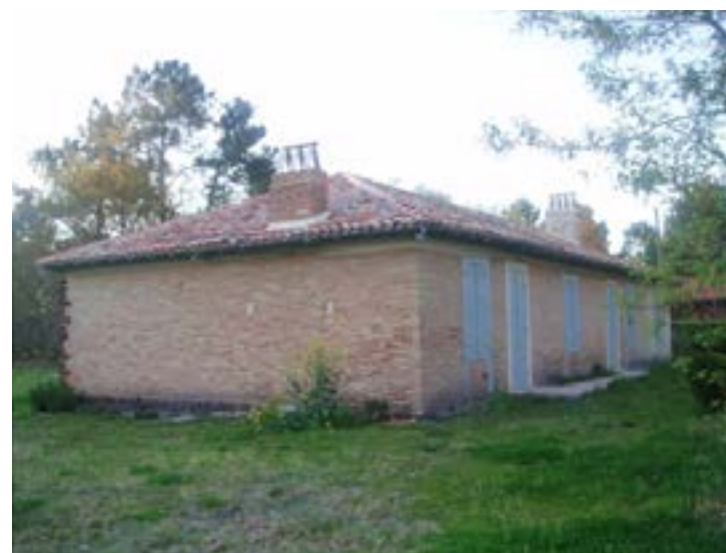
Biscarrosse, au bourg. Maison de briques plates et de garluche. Fin du XVIII ème siècle. Tuiles romanes canal. Etat actuel. Ouest.
