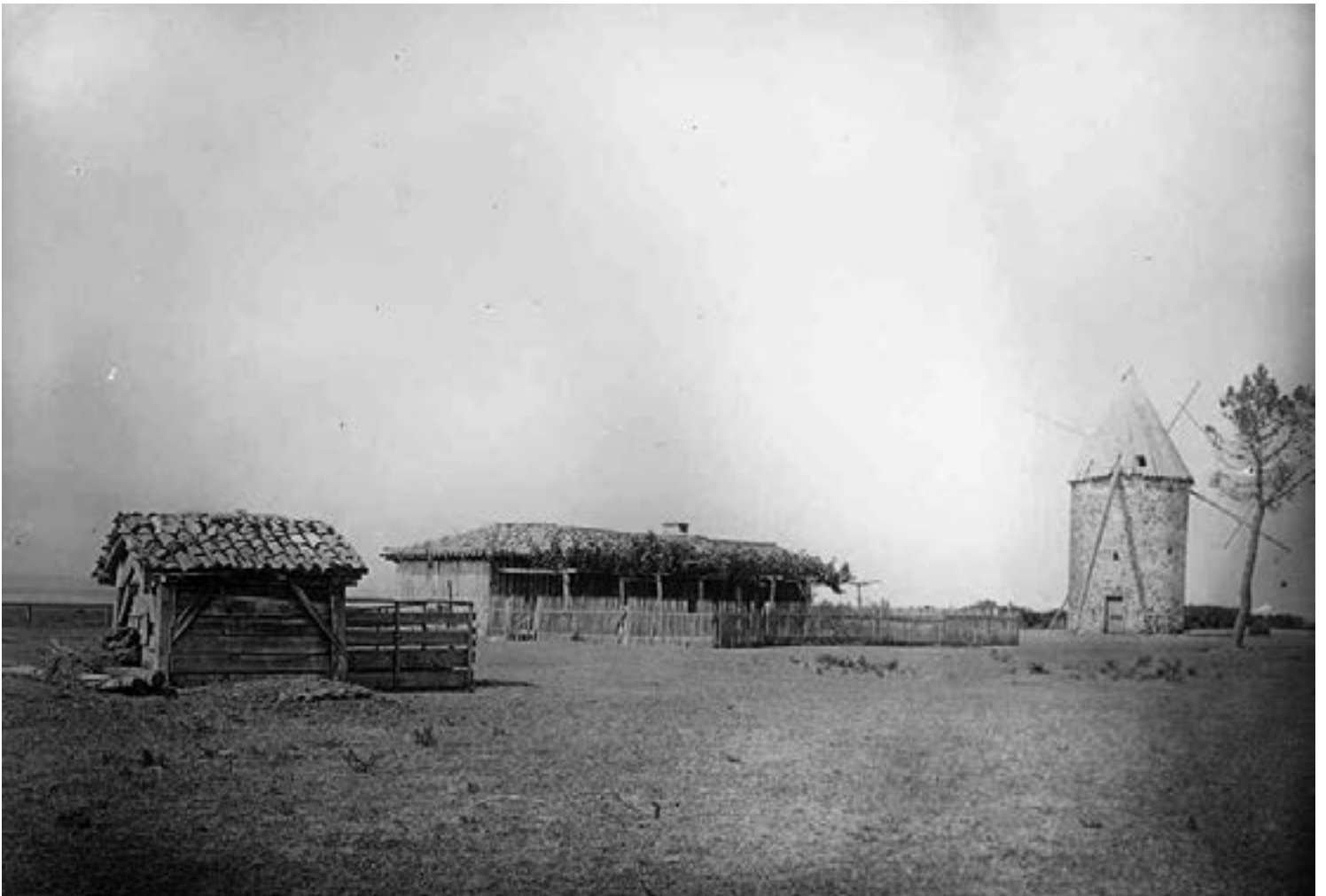
Biscarrosse, maison et moulin à vent de Cherit, En Chon, au bord de l'étang. Félix Arnaudin, le 19 août 1898.
